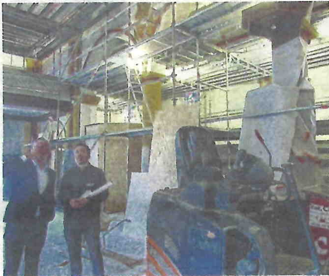
Christophe Suszylo, maire (à gauche), et Jean-Baptiste Roch, lors d'une visite du chantier restauration de l'église Saint-Laurent du Versoud. Photo Le DL
